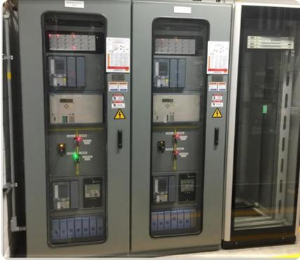
Un tablero de protección control y medición es un conjunto de gabinetes metálicos donde se ubican los relevadores de protección, los dispositivos de control, alarmas, medición, tablillas de interconexión, etc.
